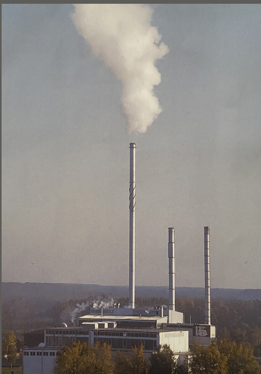
DIMNJACI ENERGETIKE , IZGRAĐENI 1983. GODINE
