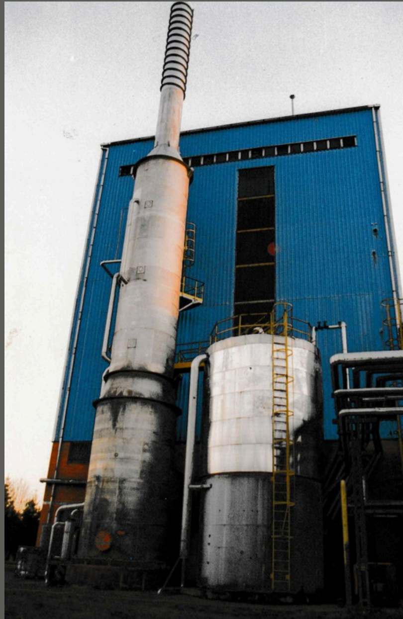
DIMNJAK POSTROJENJA COPELAND
